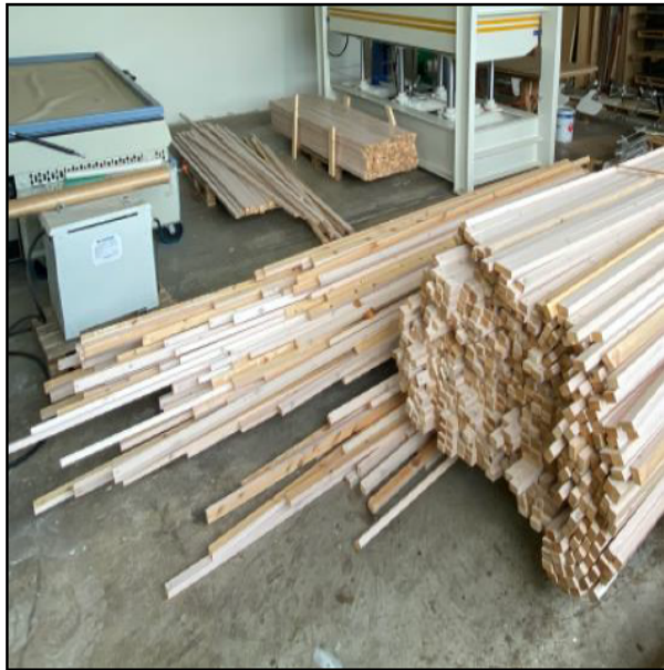
Trespiler demontert fra himling i korridor på Refstad skole. Foto: Anne S Nordby
