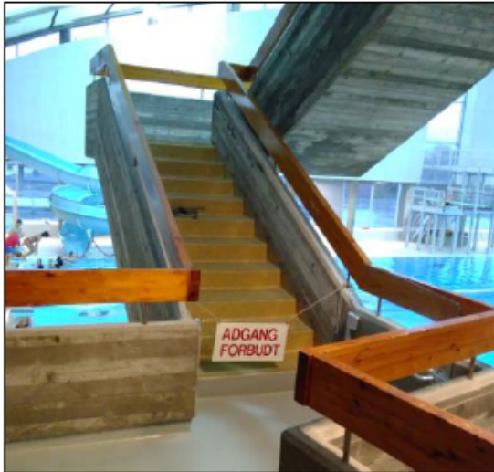
Kraftige håndløpere i tre, som del av rekkverk i Tøyenbadet. Foto: Anne S Nordby Ferdig amfitrapp. Foto: Rune Andersen Sidevange med synlig endeved. Foto: Randi Lunke
