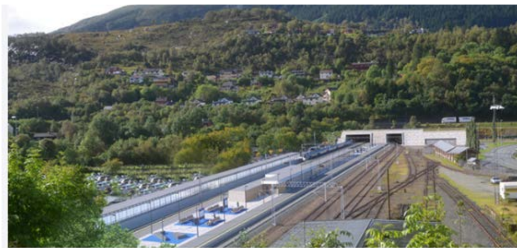
Figur 8: Prosjektet Nye Ulriken tunnel er en del av den store jernbaneutbyggingen dobbeltspor Arna-Bergen. Jernbanetunnelen med dobbeltspor er bygget parallelt med den eksisterende tunnelen mellom Arna og Fløyen. Tunnelen er totalt 7,7 km lang. Cirka 6,9 km ble drevet med tunnelboremaskin og de siste 800 m nærmest Arna ble drevet med konvensjonell boring på grunn av store og varierende tverrsnitt. Arbeidet startet i 2015, og utgjør samlet ca. 700.000 m 3 tunnelmasse [17].
