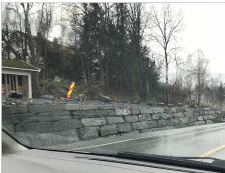
Figur 2: E6 sør for Trondheim (Ulsberg-Jaktøya). Overskuddsmasse fra veglinja anvendt som forstøtningsmur. Foto. SINTEF.
