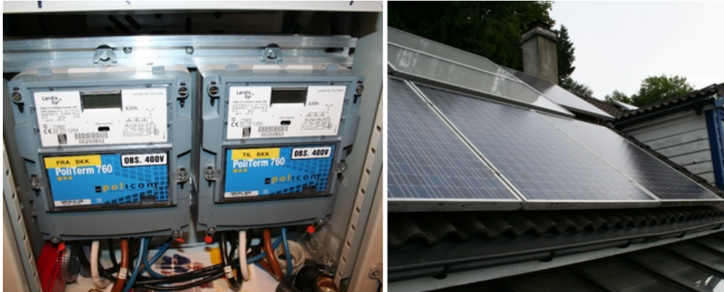
Figur 3: Måleapparat for produksjon og forbruk (t.v) og takmonterte solceller (t.h) hos plusskunden i BBKs nett. [10]
