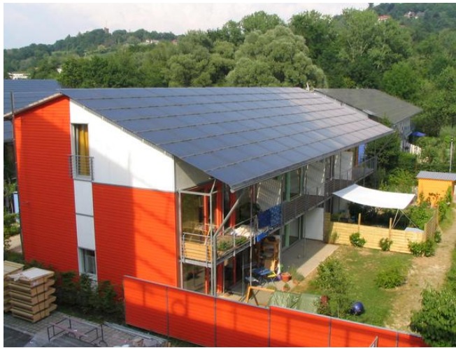
Figur 1: Plusshus i Freiburg, Tyskland [6]
