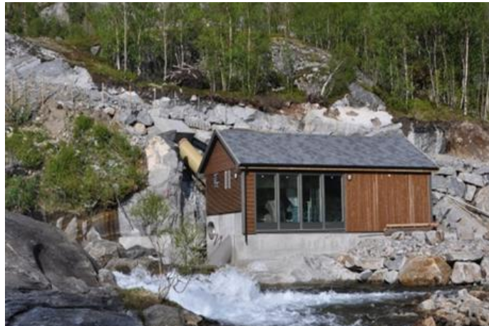
Figur 20: Kistafossen kraftverk med energiproduksjon på 5,5GWh [46]
