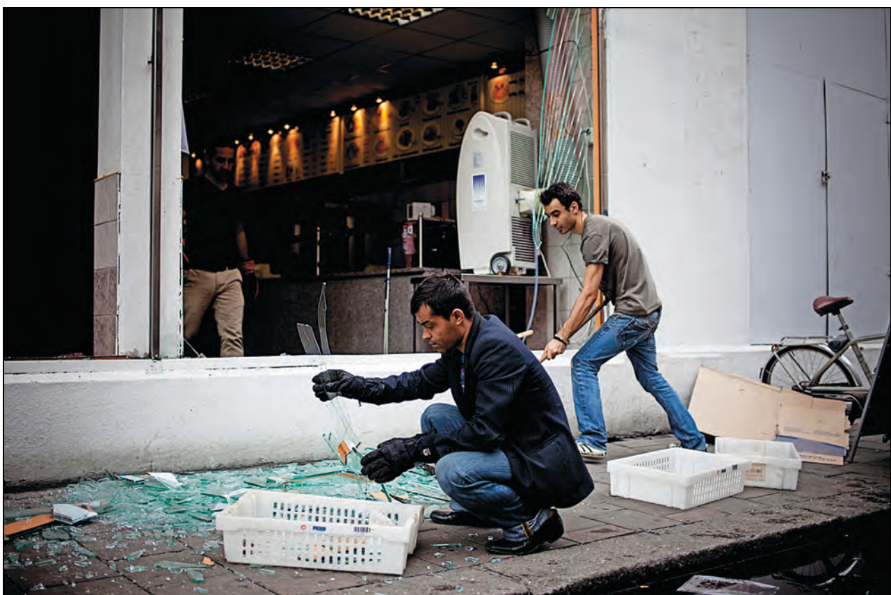
Figur 18.5 Trykkbølgen førte til omfattende vindusskader opptil 500 meter fra eksplosjonsstedet. Her fra en kafé i Dronningens gate.
