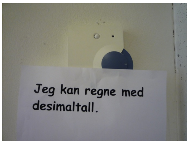
Figur 3.1 Tildekket sensor på en barneskole. Foto: Mads Mysen, SINTEF Byggforsk
