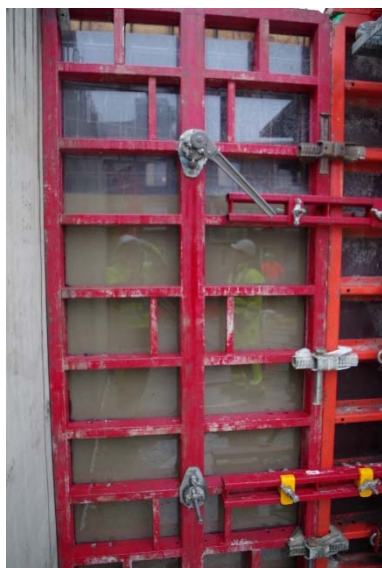
Figur 1: Her ser man produksjon av gjennomsiktig forskaling og at betongen fyller formen, inkludert evt avvik (steinreir). Foto: Andreas Sjaastad, Veidekke
