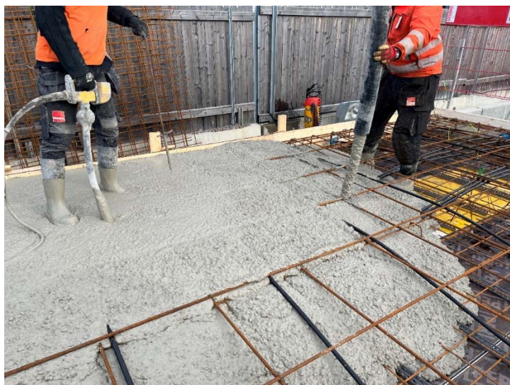
Figur 7: Prøvestøp med ekstrem lavkarbonbetong for Veidekkes nye hovedkontor. Foto: Andreas Sjaastad.
