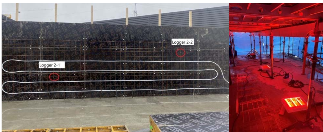
Figur 6: Noen tiltak som ble testet for å motvirke kaldt klima og senere tidligfasthetsutvikling, som infrarød varme og varmerør. Foto: Alf Egil Mathisen.
