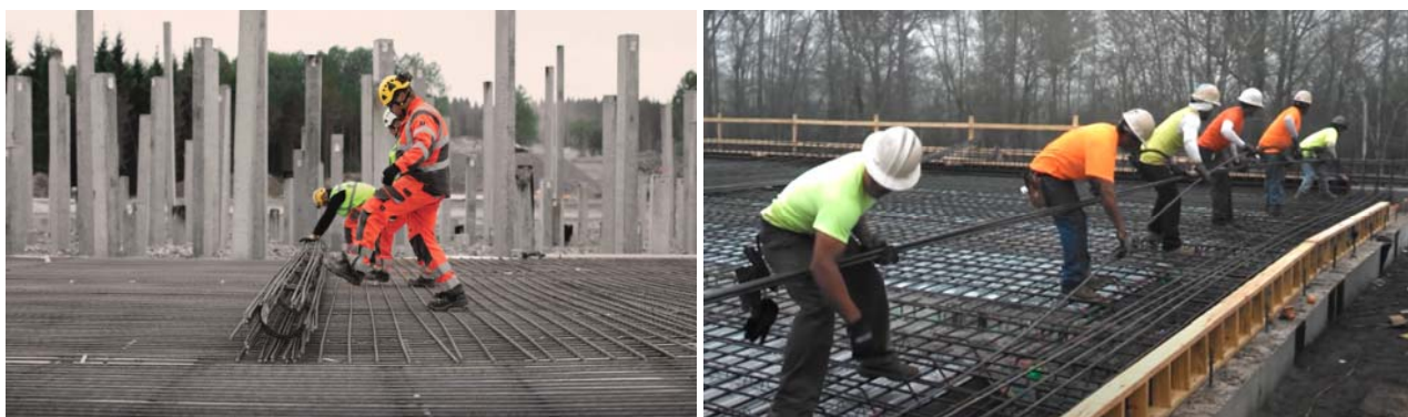
Figur 13: Legging av rullearmring vs tradisjonell løs armering. Foto: celsa-steelservice.se
