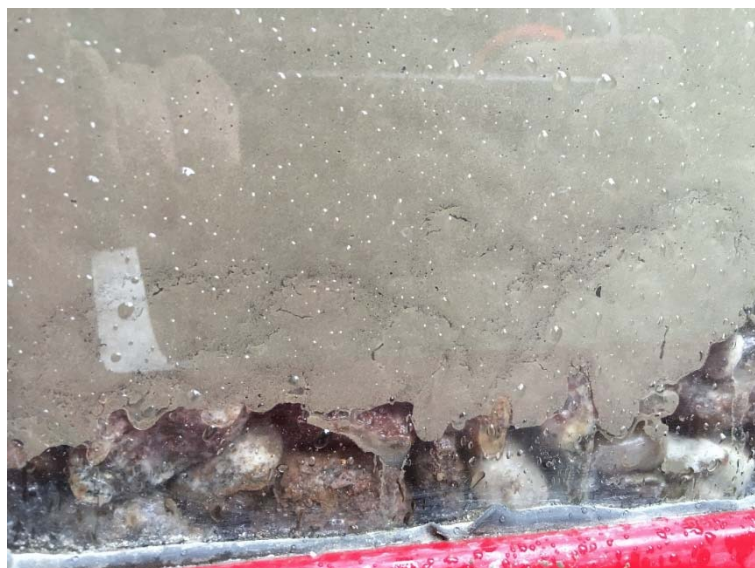
Figur 1: Her ser man produksjon av gjennomsiktig forskaling og at betongen fyller formen, inkludert evt avvik (steinreir). Foto: Andreas Sjaastad, Veidekke
