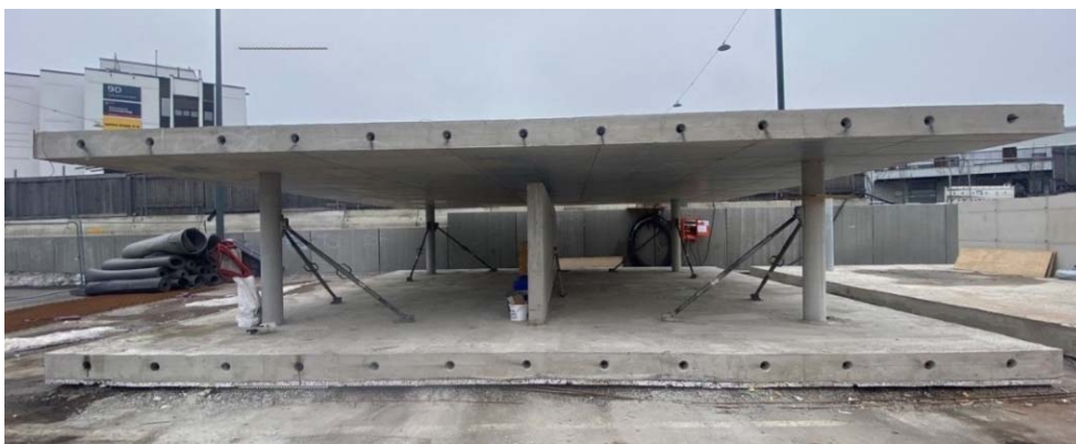
Figur 8: Etter flere prøvestøper med ekstrem lavkarbonbetong til Veidekkes nye hovedkontor. Foto: Andreas Sjaastad.
