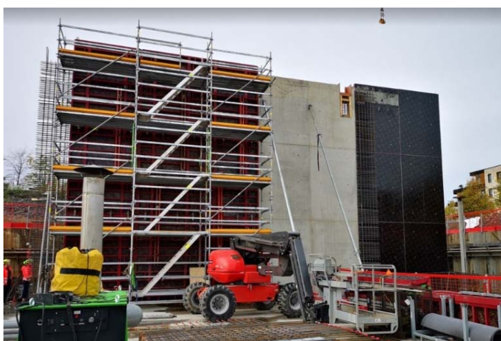
Figur 9: Vegg fra Oksenøya som skal støpes, der støpetrykk ble målt med ekstrem lavkarbonbetong. Foto: Helga Synnøve Kjos-Hanssen.
