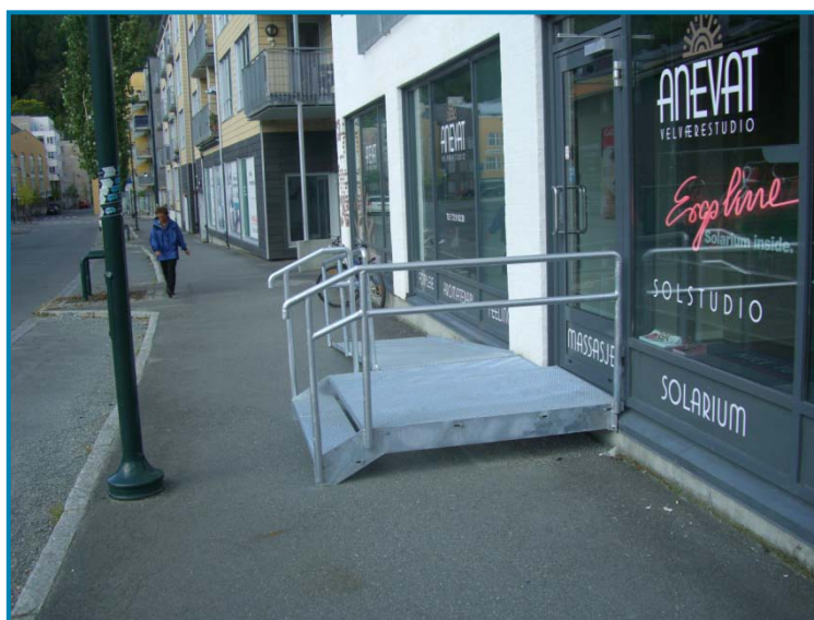
Figur 31: På dette fortauet begrenses fri bredde for ferdsel av trapp og skiltstolpe (punkthinder).
