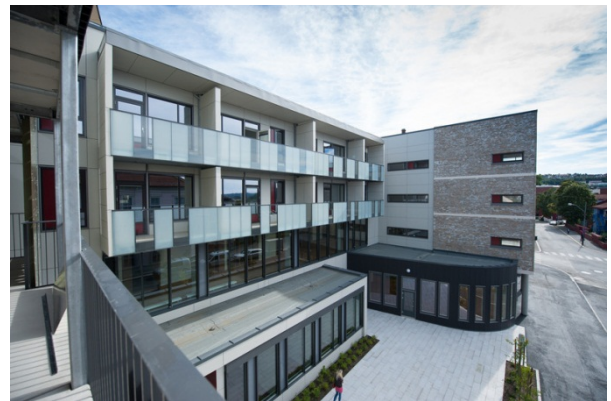
Omsorgsboliger med velferdsteknologi på Kampen i Oslo (Kampen Omsorg +)
