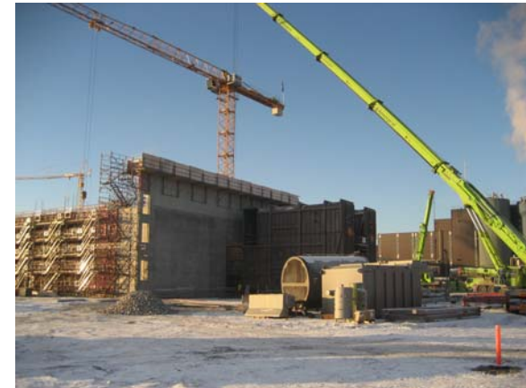
Under bygging i januar 2009
